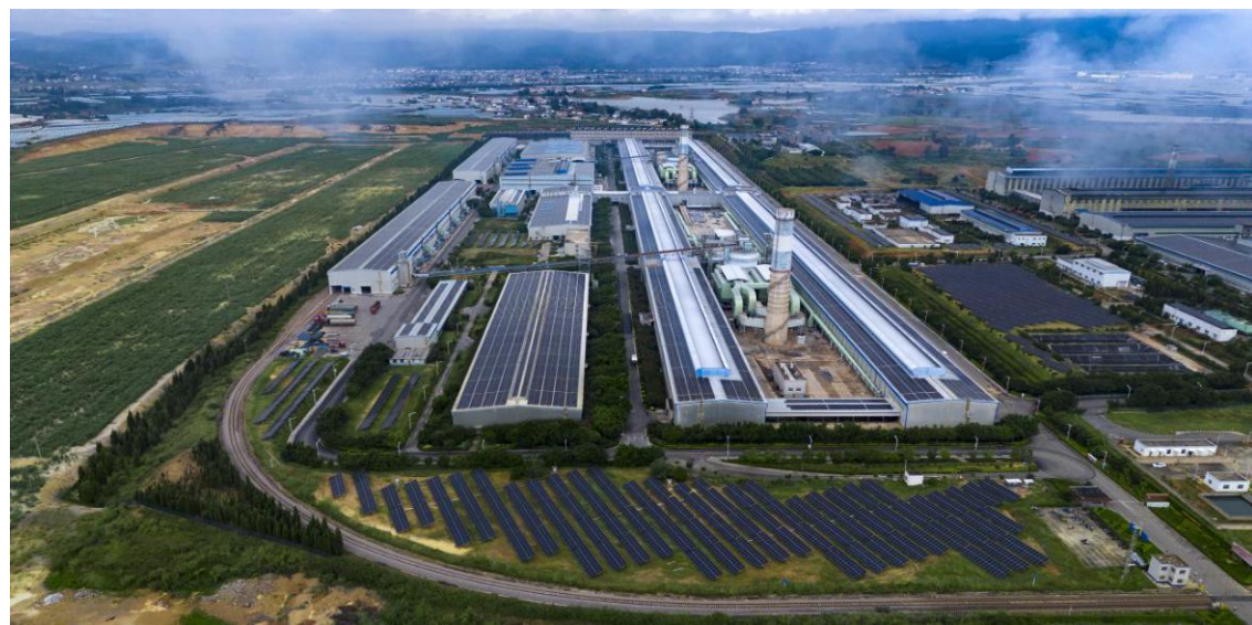
公司布式光伏发电全景
