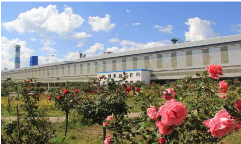
公司厂区一角
