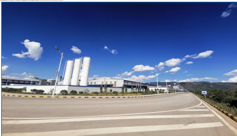
公司厂区一角
